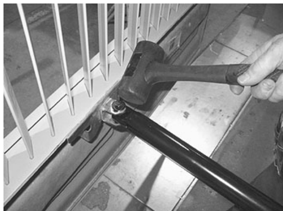
FIGURE 67 AJUSTEMENT LATÉRAL DE LA PORTE
