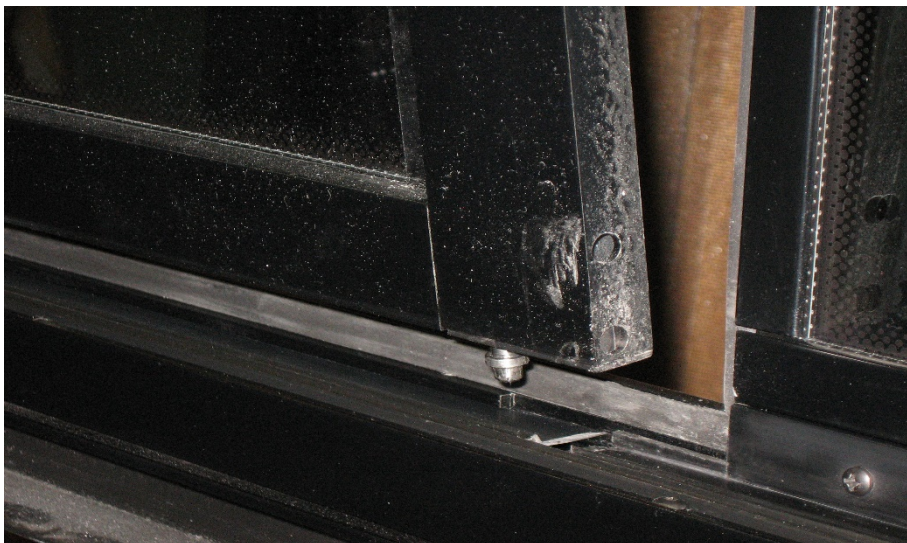
FIGURE 45: DÉGAGEMENT DU BAS DU CHÂSSIS
