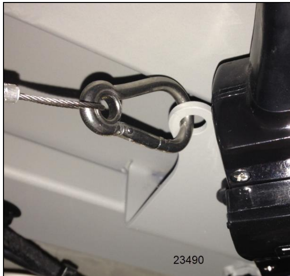
FIGURE 54: INSTALLATION DU CÂBLE DE SÛRETÉ
