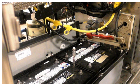
FIGURE 45 DÉGAGEMENT DES CÂBLES
