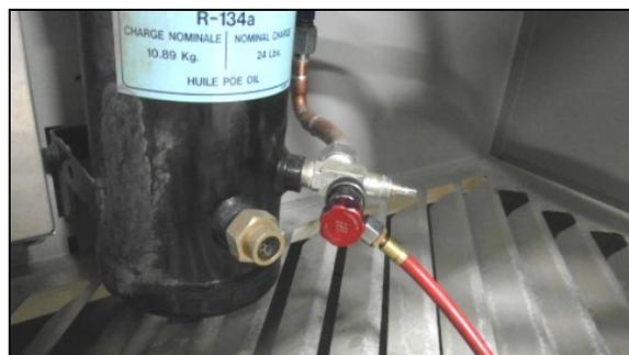
FIGURE 98 : UNITÉ DE RÉCUPÉRATION CONNECTÉE AU RACCORD DE SERVICE DU RÉSERVOIR RÉCEPTEUR
