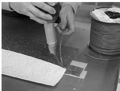
8. Le talon de la buse rapide ne doit pas toucher le revêtement de plancher (il doit toujours être parallèle à la surface).
