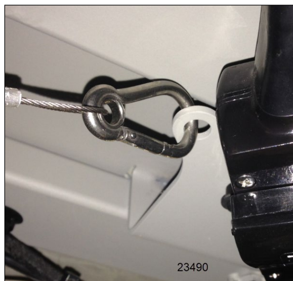
FIGURE 45: INSTALLATION DU CÂBLE DE SÛRETÉ
