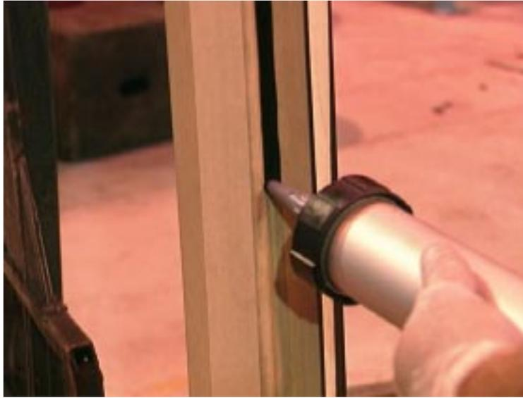
8. Installer le joint de caoutchouc sur le cadre.
