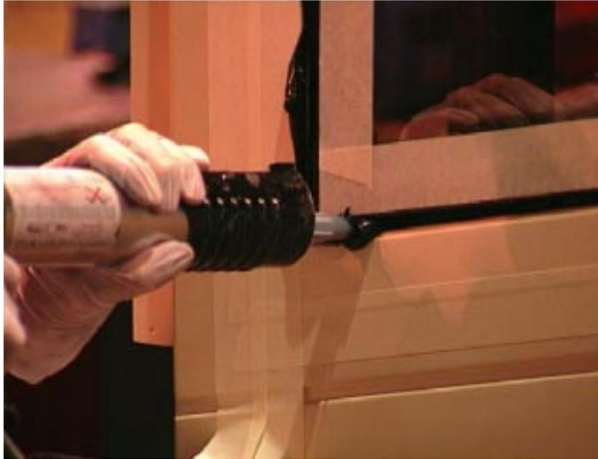
10. Utiliser une lame de plastique (Prévoist # 682838) pour enlever l'excédant de produit d'étanchéité. Au besoin, asperger d'eau savonneuse et lisser avec le doigt.
