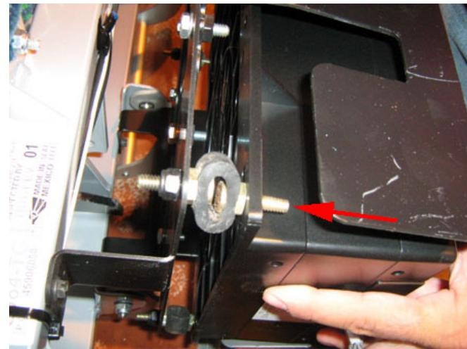
Fixer le caisson sur son support à l'aide de 4 rondelles plates (500877) et de 4 écrous (502874).
