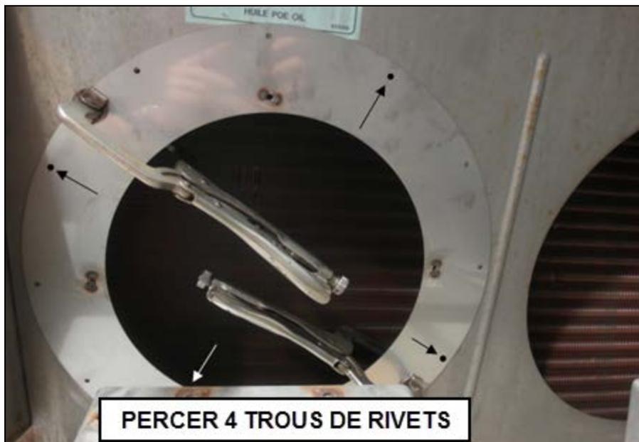
8. Fixer l'anneau au carénage avec les rivets fournis insérés dans les 4 trous précédemment percés (enlever les étaux en C).
