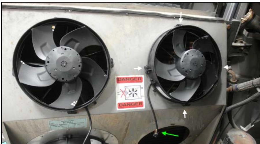
24. Placer l'anneau adaptateur sur l'ouverture du ventilateur inférieur (extérieur) et le tenir en place à l'aide de deux pinces étaux (en C); s'assurer que l'anneau est centrée sur l'ouverture et qu'il y a suffisamment d'espace (de métal) autour des trous de rivet.
