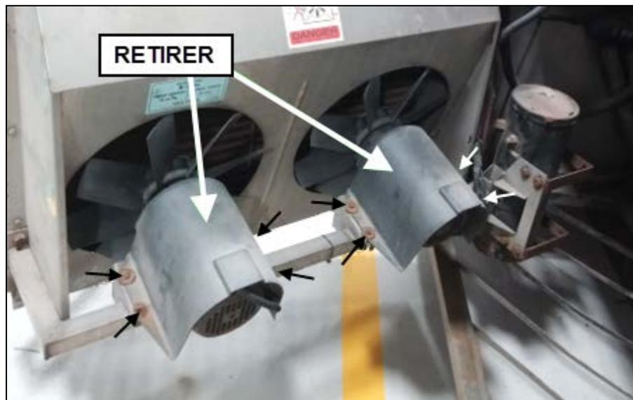
4. Débrancher les harnais électrique des deux ventilateurs et couper les attaches de câble pour séparer le harnais du carénage de ventilateur.
