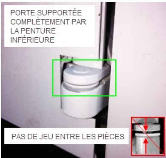
FIGURE 7: APPUI SUR LA PENTURE INFÉRIEURE
