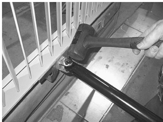
FIGURE 70 AJUSTEMENT LATÉRAL DE LA PORTE
