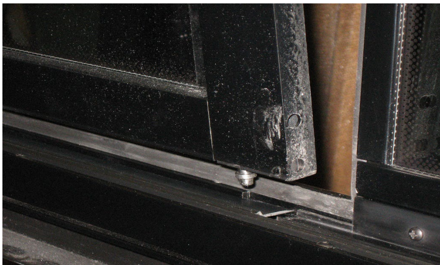
FIGURE 48: DÉGAGEMENT DU BAS DU CHÂSSIS
