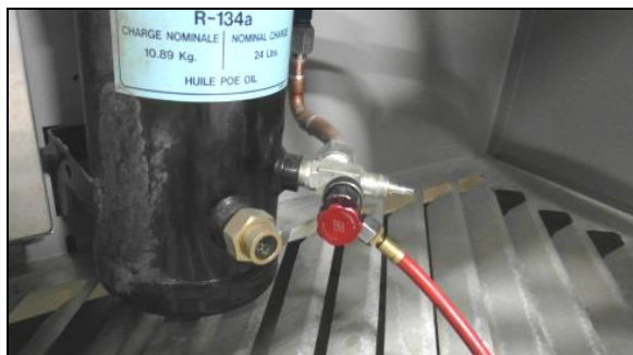
FIGURE 100 : UNITÉ DE RÉCUPÉRATION CONNECTÉE AU RACCORD DE SERVICE DU RÉSERVOIR RÉCEPTEUR
