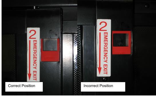
FIGURE 112: RELEASE LATCH PROPER POSITION
