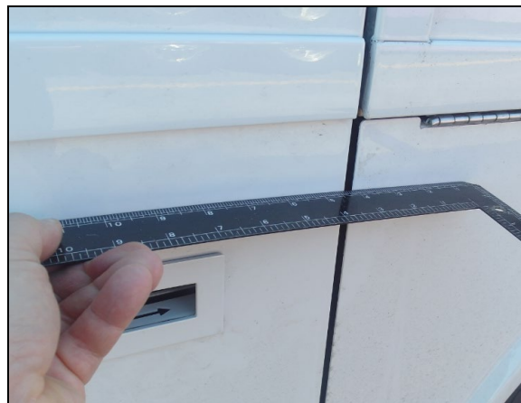
FIGURE 62: UTILISER UNE RÈGLE POUR VÉRIFIER SI LES SURFACES SONT AU MÊME NIVEAU
