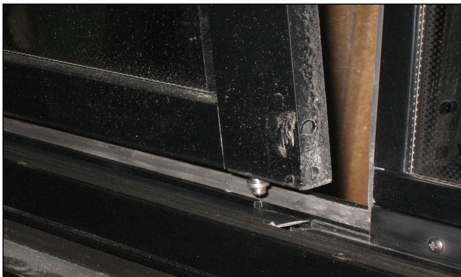
FIGURE 103: DÉGAGEMENT DU BAS DU CHÂSSIS
