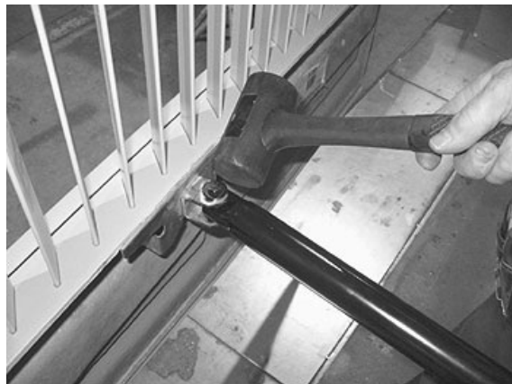
FIGURE 70 AJUSTEMENT LATÉRAL DE LA PORTE
