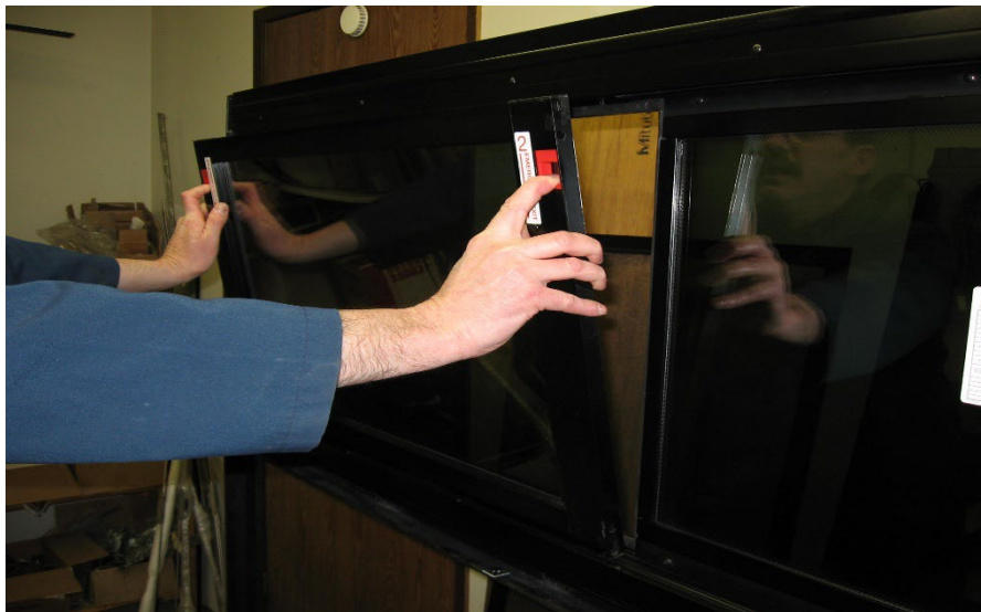
FIGURE 47: RETRAIT DU CHÂSSIS
