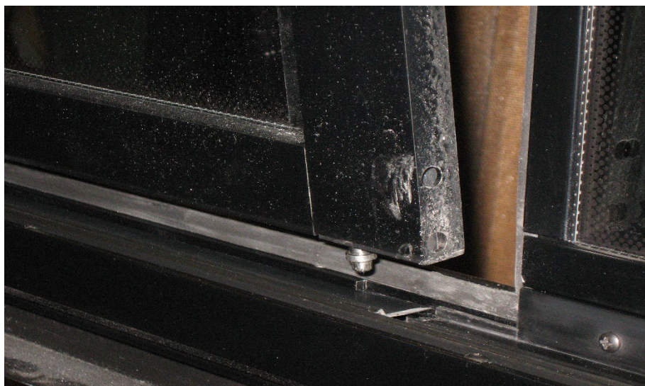
FIGURE 48: DÉGAGEMENT DU BAS DU CHÂSSIS
