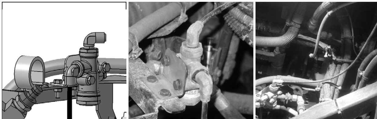
INSTALLATION DE LA VALVE RV-3 – NOUVEL EMPLACEMENT
