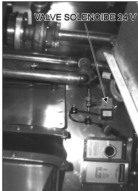
FIGURE 4: COMPARTIMENT DE CHAUFFAGE ET DE CLIMATISATION
