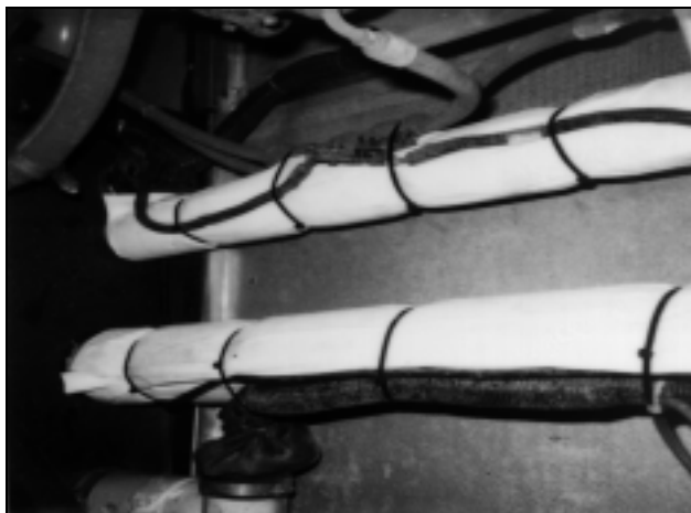
FIGURE 7: VUE DE L'ISOLANT SUR LES DEUX CONDUITS
