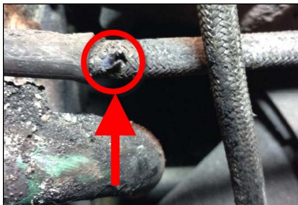
FIGURE 7: EXEMPLE DE DOMME À LA SECTION DE GAINE TRESSÉE CAUSÉ PAR LA LIGNE DE LIQUIDE DE REFROIDISSEMENT
