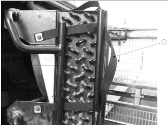
SANGLE DE L'ENSEMBLE DE CONDENSEUR
