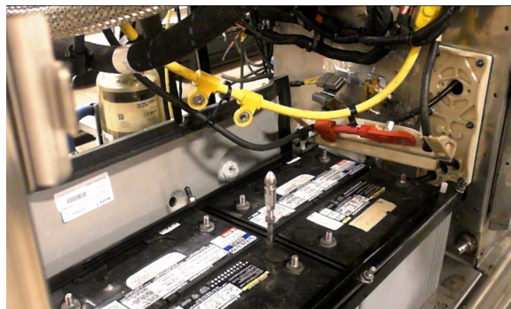
FIGURE 44 DÉGAGEMENT DES CÂBLES
