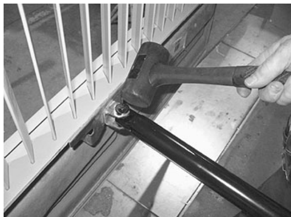
FIGURE 73 AJUSTEMENT LATÉRAL DE LA PORTE
