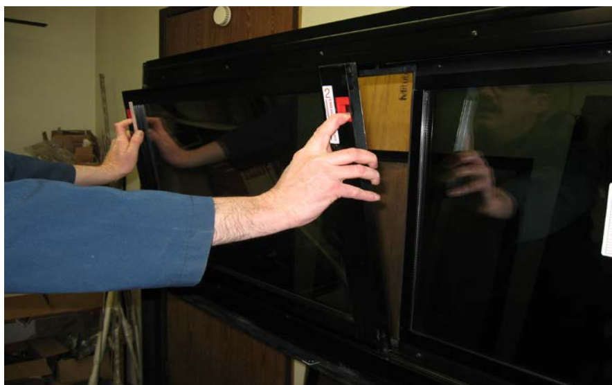
FIGURE 50: RETRAIT DU CHÂSSIS
