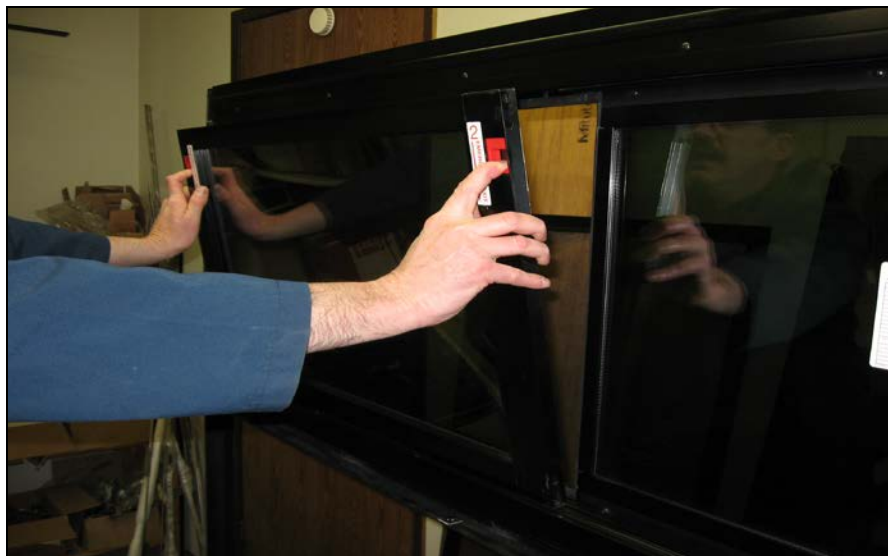
FIGURE 95: RETRAIT DU CHÂSSIS
